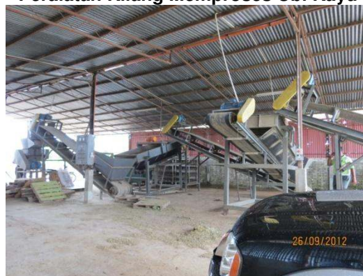
Gambar 5.3 Peralatan Kilang Memproses Ubi Kayu
