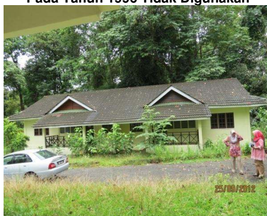
Gambar 3.6 Antara 5 Kuarters Yang Siap Dibina Pada Tahun 1996 Tidak Digunakan
