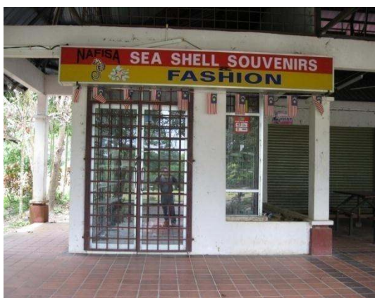
Gambar 3.5 Antara Kedai Yang Tidak Digunakan
