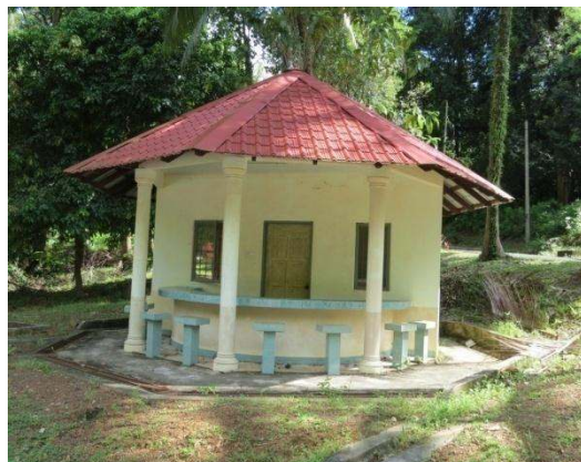
Gambar 3.4 Kedai Yang Dibina Tidak Digunakan
